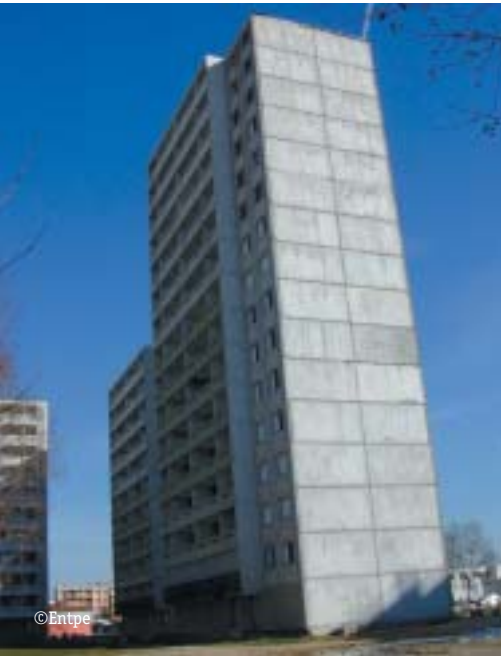
SEPT BÂTIMENTS DE TYPE HLM, CONSTRUITS ENTRE 1965 ET 1975, ONT ÉTÉ AUSCULTÉS.
